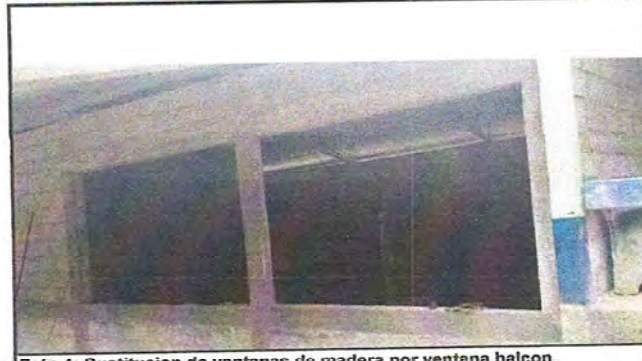
Foto 4: Sustitucion de ventanas de madera por ventana balcon
