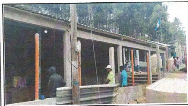
Foto 3: Colocacion de Puertas y ventanas de metal con vidrio
