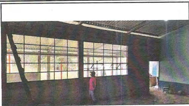
Foto 2: Repello e instalacion de Laminas troqueladas
