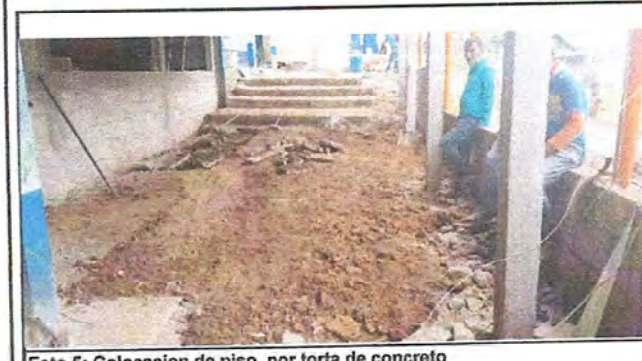
Foto 5: Colocacion de piso, por torta de concreto
