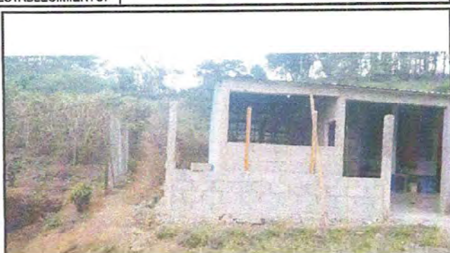
Foto 1: Circulación de muro de contención, con block y tubo
